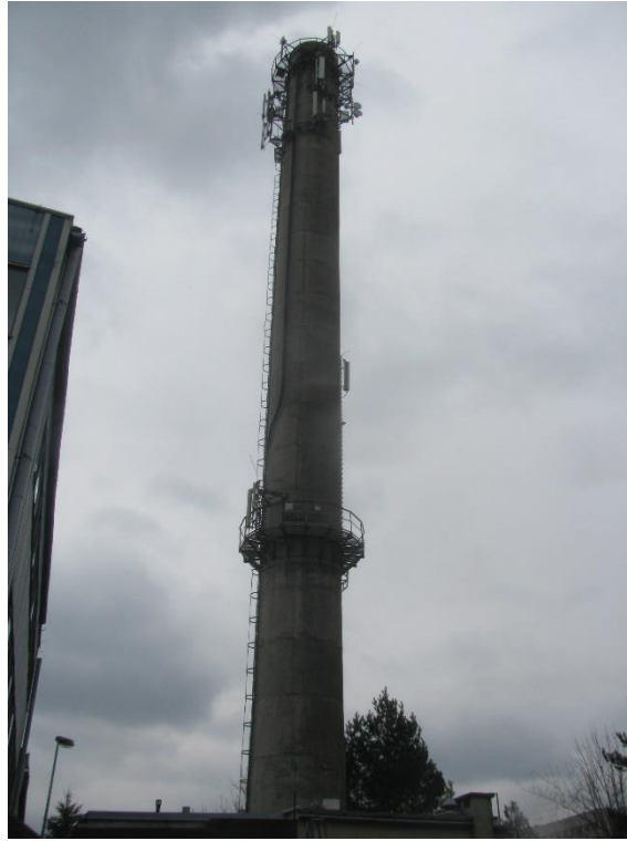
Zał. nr 1: Widok ogólny instalacji radiokomunikacyjnej.
